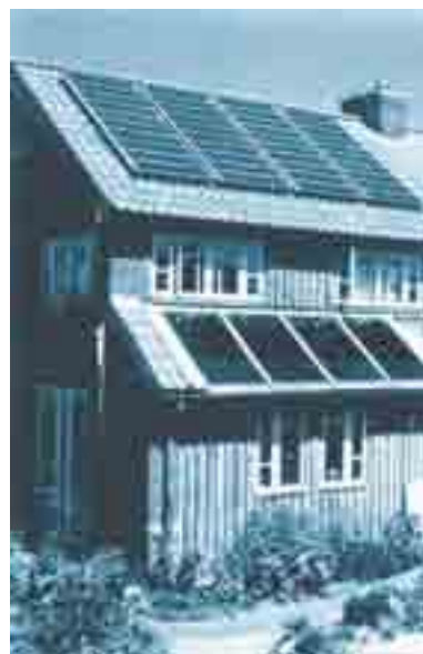
Hình 46.3 Ảnh một ngôi nhà được cấp điện bằng những tấm pin Mặt Trời chế tạo từ bán dẫn silic, đặt trên mái nhà.
