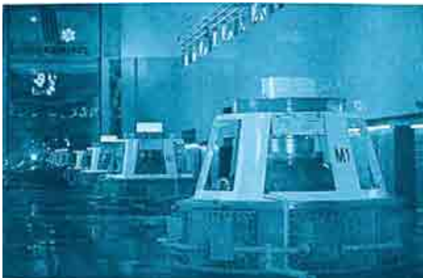
Các tổ máy phát điện tại gian máy của Nhà máy thủy điện Y-a-li.
