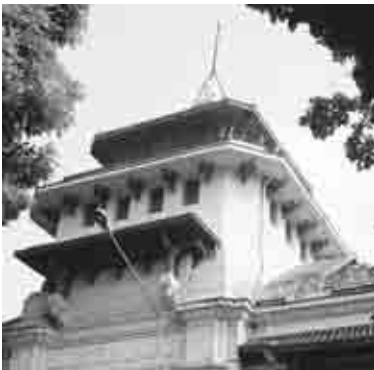
Hình 22.6 Cột chống sét.
